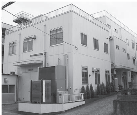
資料2 本社ビル
