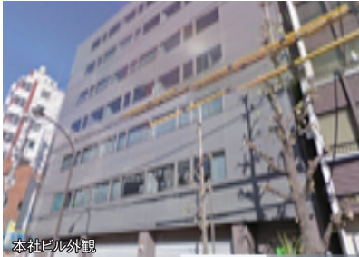
本社ビル外観
